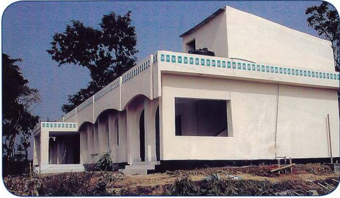
مشروع بناء الجامعة الإسلامية بمدينة سلهت في قرية «تواكل تواكل»، وقد انتهى العمل فيها في ١٦/٤/٢٠٠٧م
