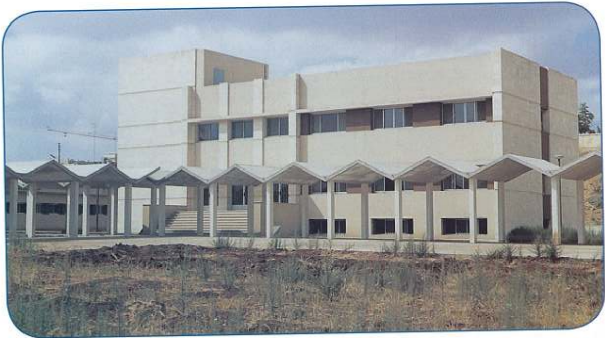
مشروع مدينة أبناء الشهداء بحلب بناء الصفوف - الواجهة الرئيسية تبرع «اللجنة الشعبية لجمع التبرعات - الصفا الكويت»
