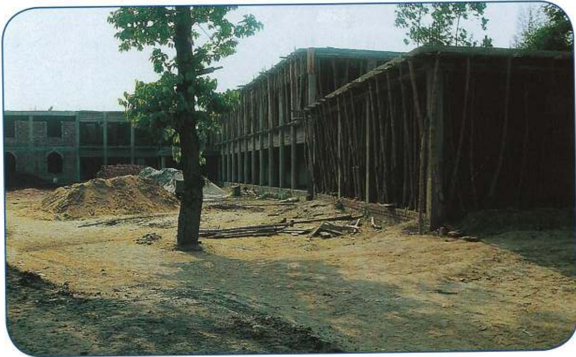
مشروع بناء المدرسة المتوسطة في مدينة غازي بور في دولة بنغلادش، وقد تم صب سقف الدور الثاني في ١٠/٤/٢٠٠٧م
