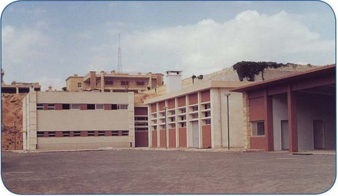
مشروع مدينة أبناء الشهداء بحلب من اليمين إلى اليسار المرآب - بناء المراجل - بناء مصلحة الفسيل
