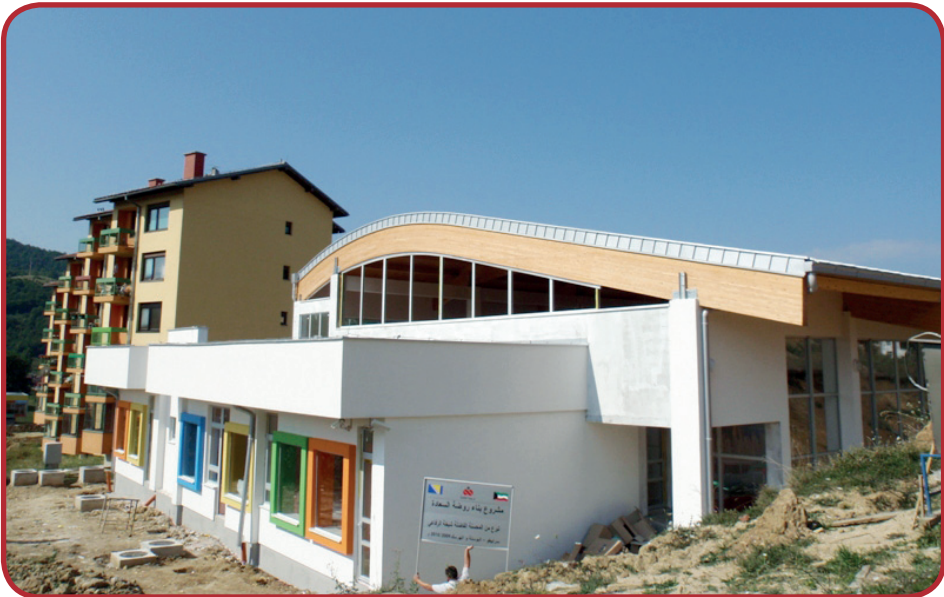
مبنى الروضة من الخارج
