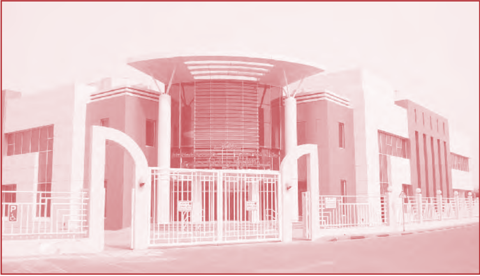
الواجهة الخلفية لمركز عبدالله وشريفة المحري الصحي
